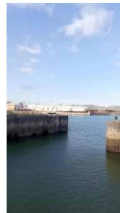
Diques de los antiguos astilleros
